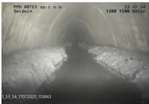
Zdjęcie 17. Kolektor deszczowy
